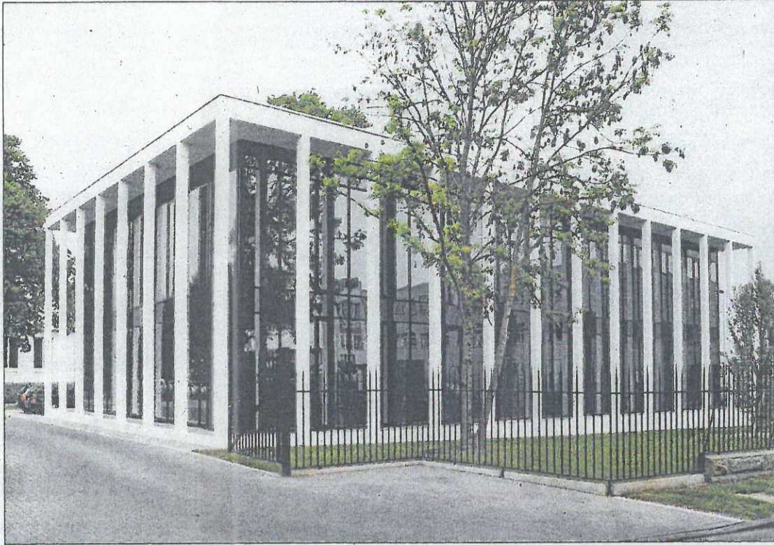
Neben dem früheren Militärgebäude am Opmünder Weg in Soest ist dieses Büro- und Handelshaus („Kontor 50“) errichtet worden.
